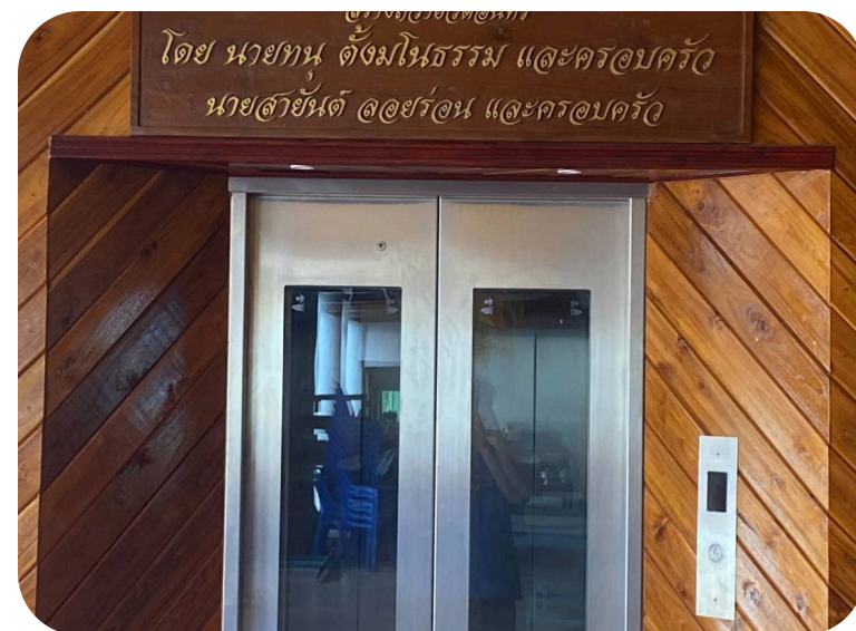
ติดตั้งลิฟต์โดยสาร อาคารสำนักงาน บริจากวัด
