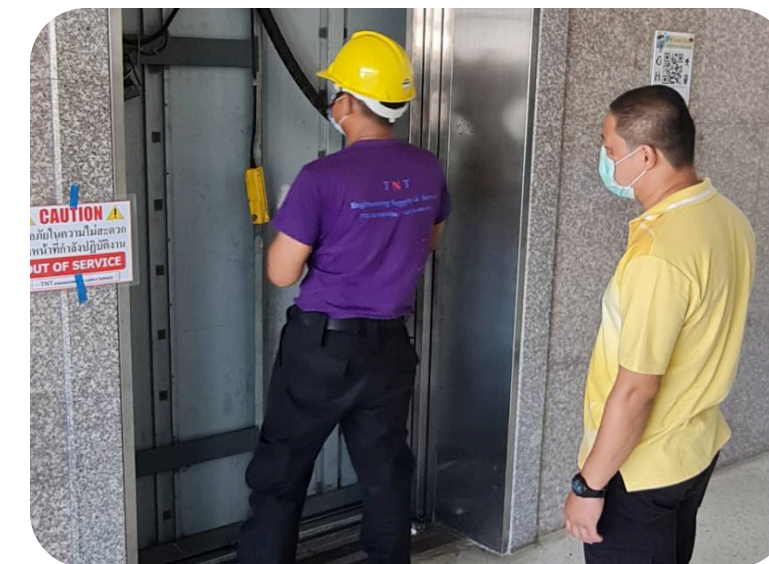
ติดตั้งลิฟต์โดยสาร อาคารสำนักงาน
